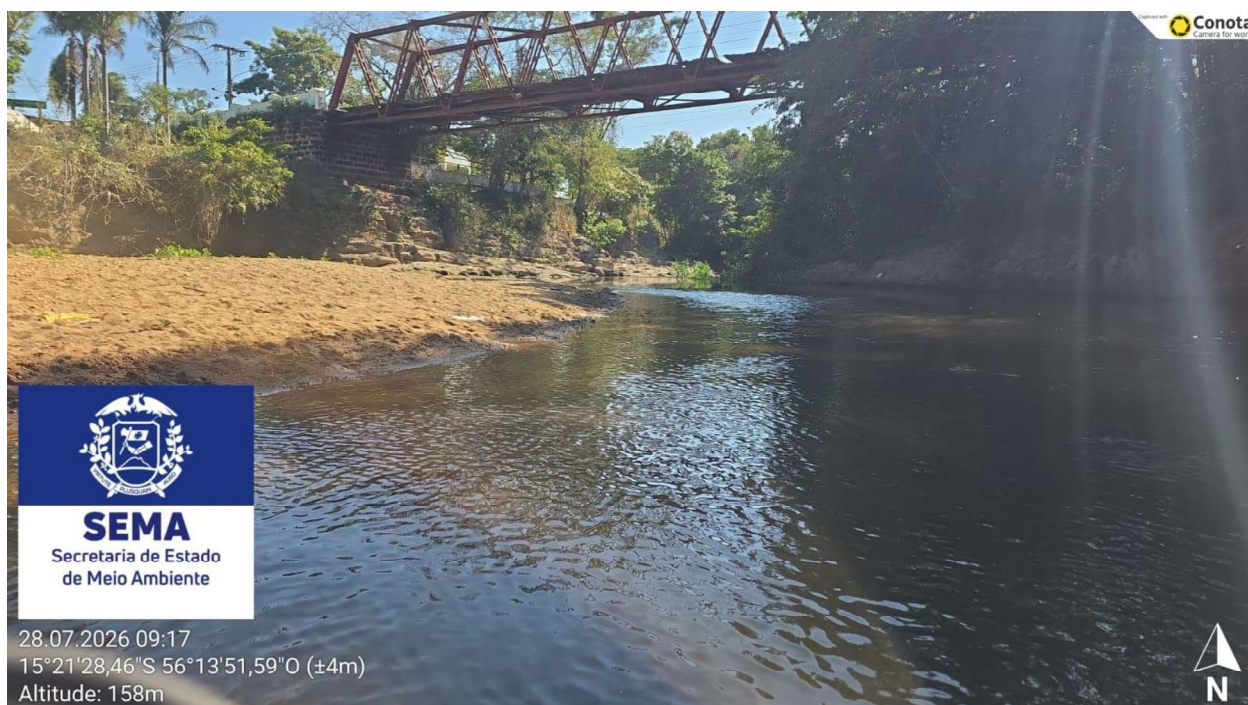
Rio Coxipó Açú – Ponte de Ferro da Guia
