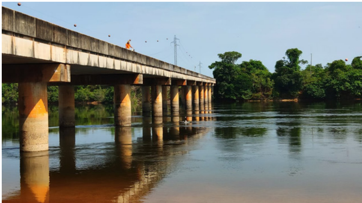
Figura 2 – Rio Juruena – Ponte em Juína.
